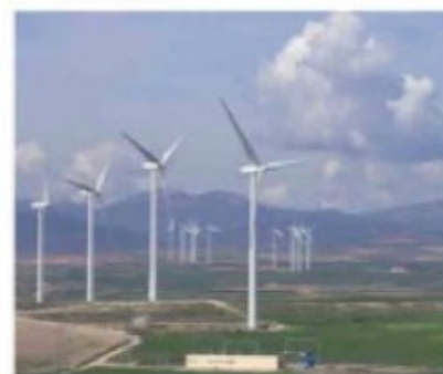
Producción de energía eléctrica sin emisiones de dióxido de carbono
